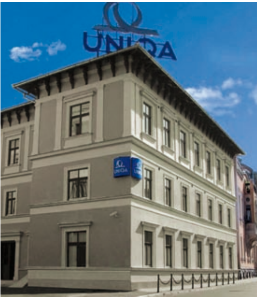
In einem liebevoll renovierten historischen Studentenheim finden nun die MitarbeiterInnen in Sarajevo seit September 2009 ihren neuen Arbeitsplatz.
